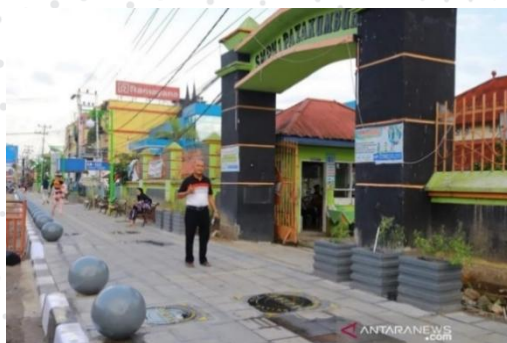
Kegiatan Drainase dilengkapi trotoar yang nyaman
