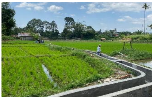
Kegiatan Rehabilitasi Irigasi Permukaan
