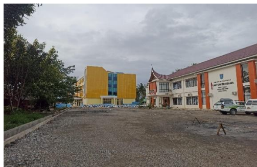
Pembangunan landscape Kantor Dinas Kesehatan, Inspektorat, dan Dinas Sosial
