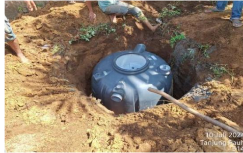
Pemerintah Kota Payakumbuh Melalui Dinas Perkim melakukan pembangunan Tank Septic Aman
